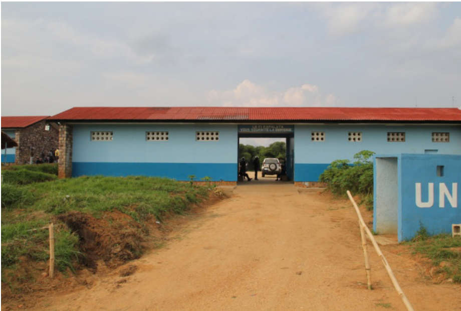
Entrée du Centre d'Instruction de Kapalata entièrement renové
