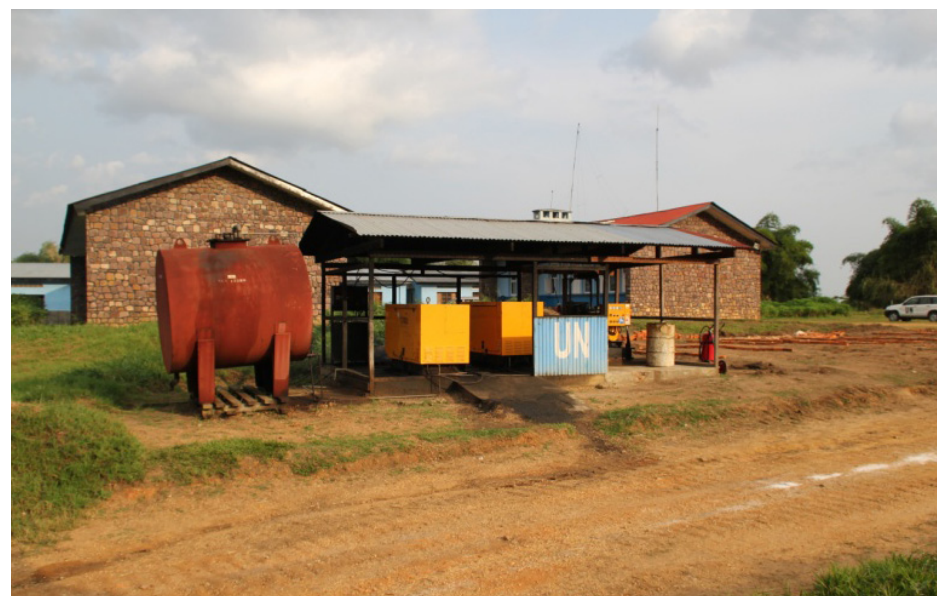
...les groupes electrogène équipé d'un reservoir avec une capacité de 5000 Litres
